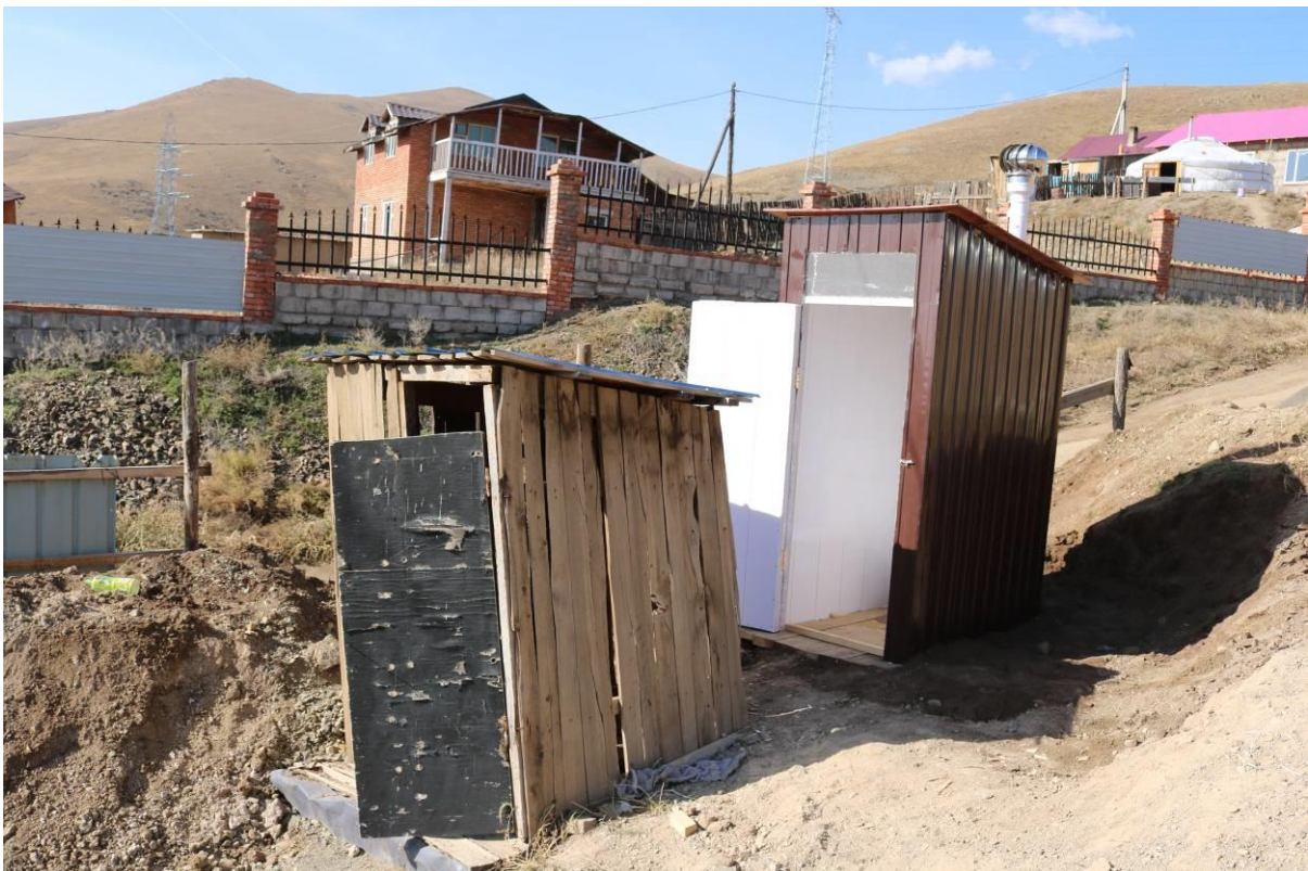
Construction d'une nouvelle latrine pour une famille avec enfant handicapé
